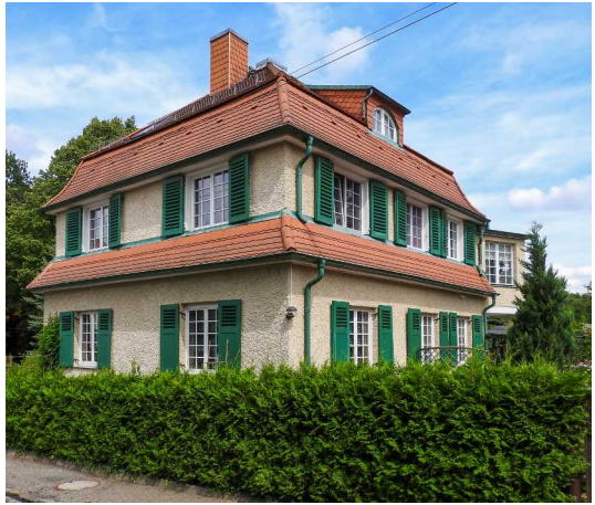
Haus im Villenviertel.
