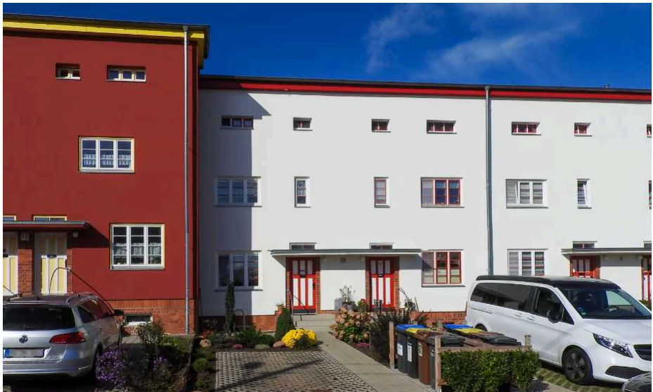
Reihenhäuser im Lilienweg, fünfte Bauphase, Ausführung mit Flachdach. (Foto: Ronald Börner)
