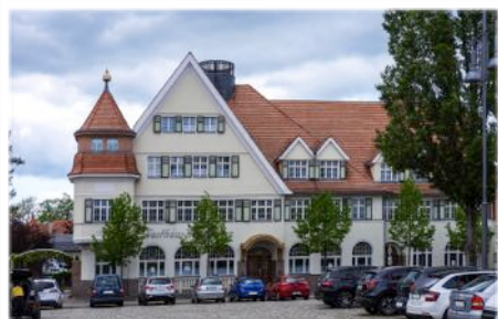
Ehemaliges Gasthaus+Hotel Kaiserkrone; heute teilweise als Grundschule und soziale Einrichtungen genutzt
