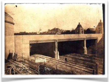
historische Brückendarstellung (Quelle: Stadt Leipzig, Archiv VTA, Bauakte)
